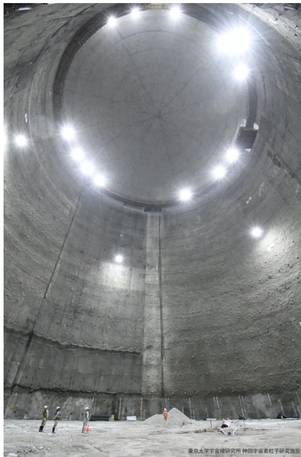
掘削が完了したハイパーカミオカンデの本体空洞
