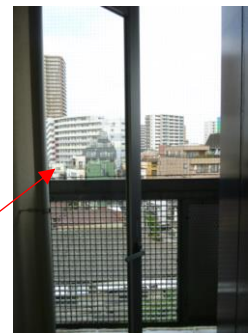
鳩除けネット設置済み (2階以上)
